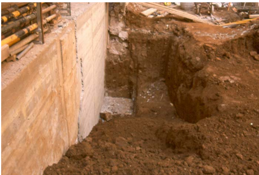
6. Treballs de rebaix del solar
