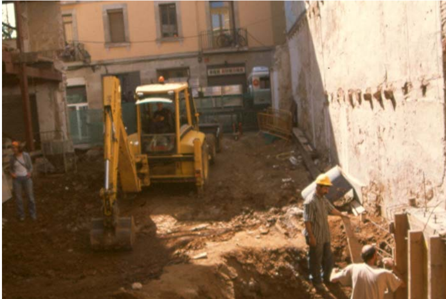
1. Treballs de sanejament del solar i excavació de sondejors
