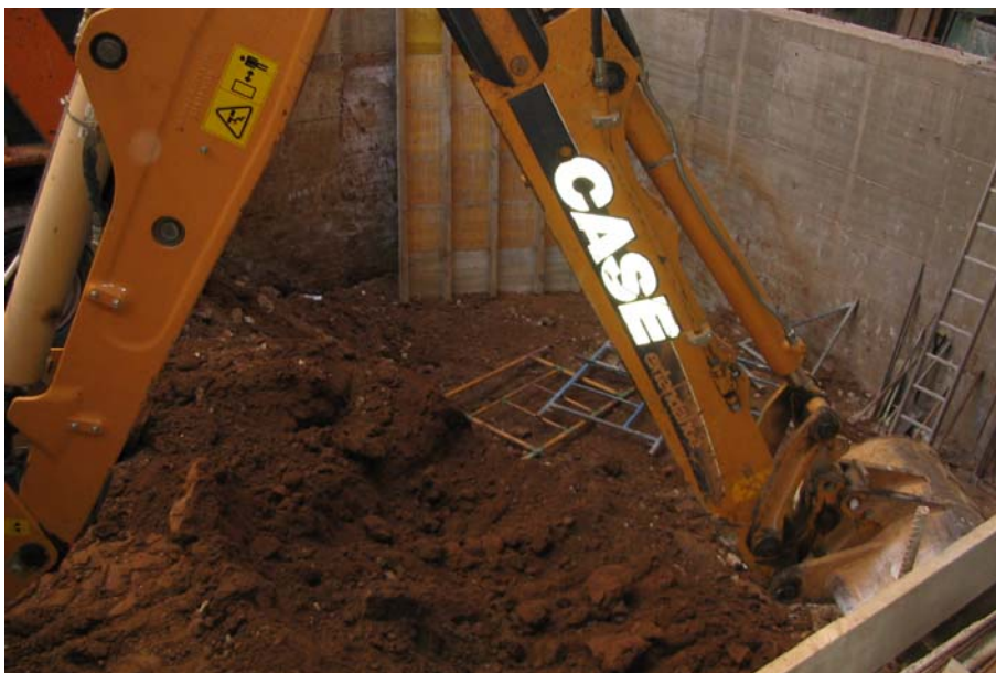
5. Treballs de rebaix del solar
