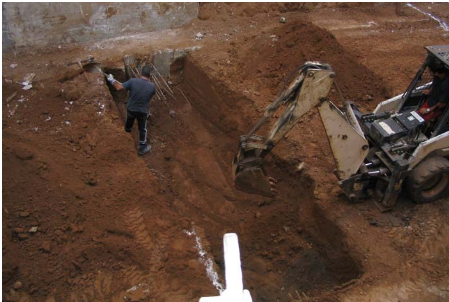
7. Treballs de rebaix del solar i construcció d'encofrats
