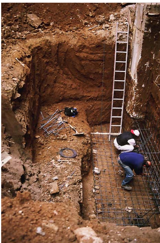
3. Treballs d'encofrat dins el sondeig 2
